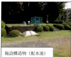
施設構造物(配水池)
