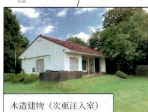
木造建物(次亜注入室)
